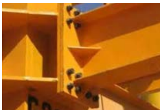
شکل ۱۸-۳ سازه فلزی اتصال پیچ و مهره (ب)
