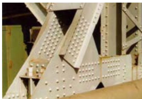
شکل ۱۸-۳ سازه فلزی اتصال پرچی (الف)
